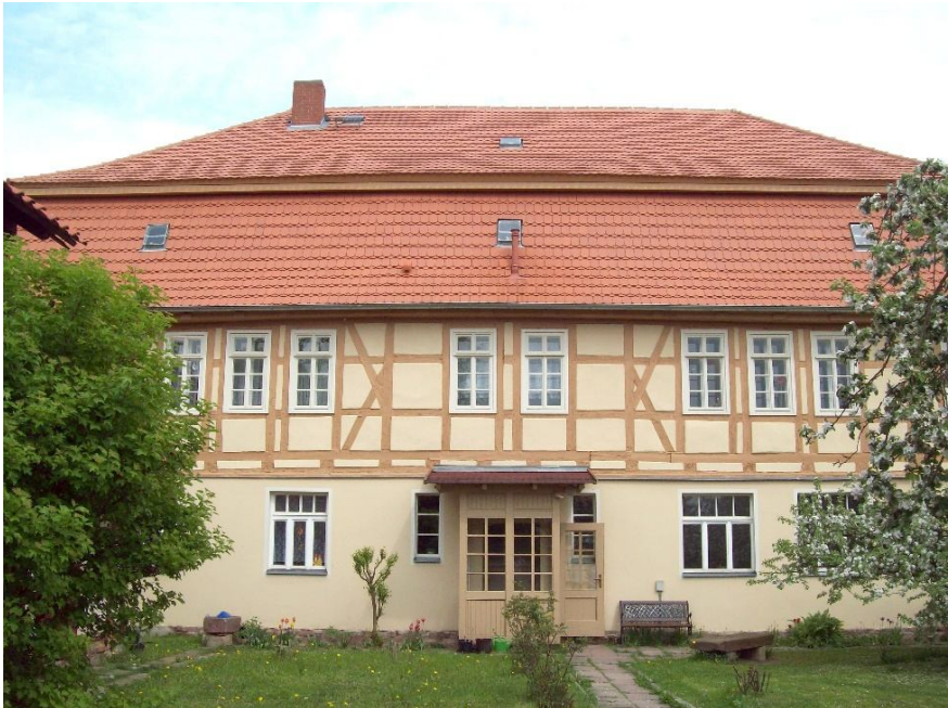
Das schucke Pfarrhaus heute mit vier vermieteten Wohnungen, die uns heute helfen, dieses Haus aus eigener Kraft zu erhalten. (Foto: Indre Lange)
