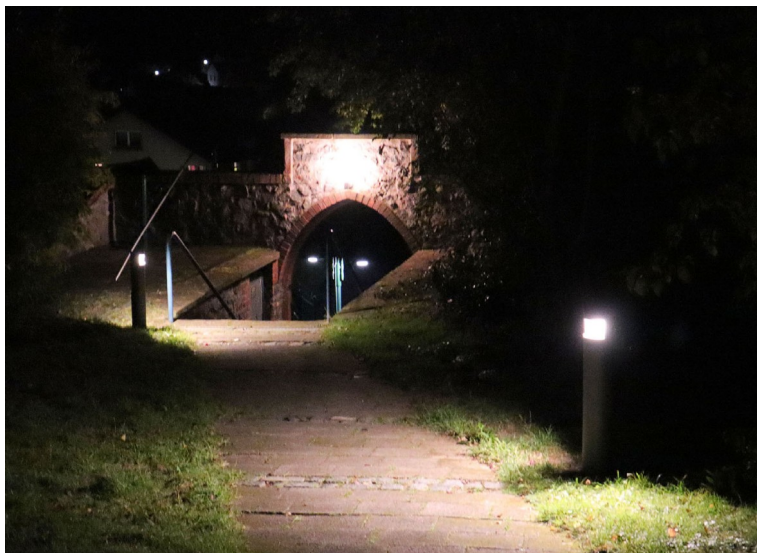
Neue Aussenbeleuchtung der Nieder-Beerbacher Kirche
